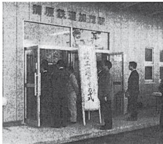
蒲原鉄道加茂駅（加茂駅西口）竣工式の様子（S53.12.26）
